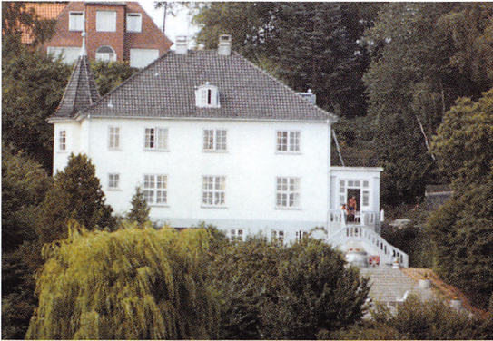
"Henico" set fra haven med de nye trapper, 1983.
