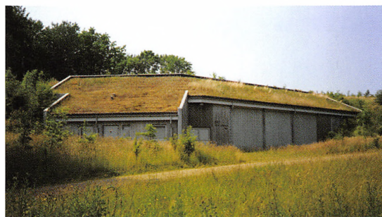
Det nye Østre Vandværk fotograferet i juli 1995 af Poul Erik Jensen.
