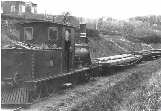
Egtvedbanens spor tages op på strækningen mellem Statsbanegården og Nordbanegården i efteråret 1930.
