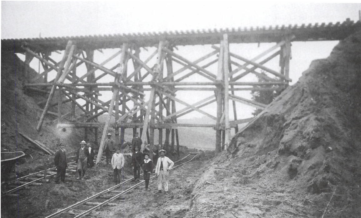
Udgravning til Troldhedebanen under Egtvedbanen i Bramdrupdam, 1915-1916.
