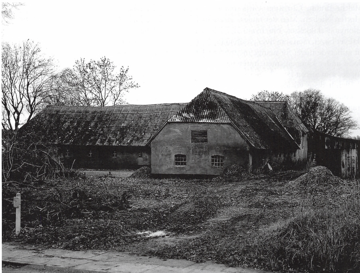
De røde staldbygninger kort før nedrivningen i 2004.
