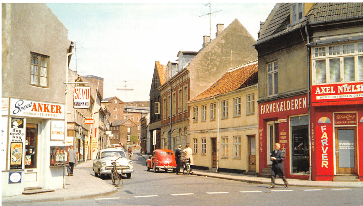
Vestergade set mod nord. I baggrunden bagsiden af Kolding Rådhus, en ombygning af det gamle arresthus. Foto fra maj 1963 af Gudrun Hechmann.
