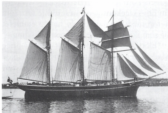
"Ella Eff" med alle sejl sat. En tremastet bramsejlskonnert var kendetegnet ved at fokken bar et gaffelsejl og tre råsejl. Foto: Svendborg Søarkiv.
