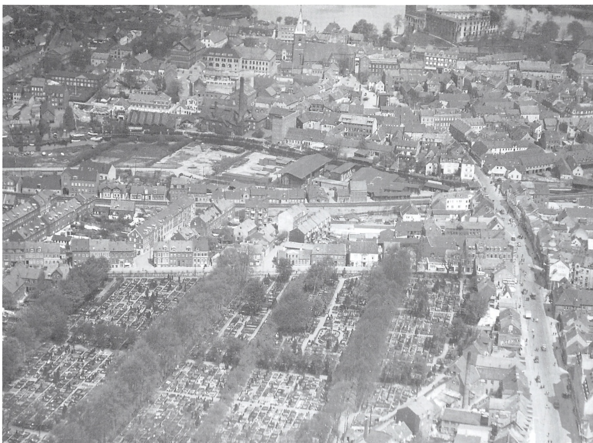
Luftfoto fra 1936 med Den Gamle Kirkegård i forgrunden. Haderslevvej ses i højre side og går direkte over i Søndergade ind i den indre by. Midt i billedet skærer banelinien igennem. Sct. Nicolai Kirke og gymnasiet ses i baggrunden. Bredgade er endnu ikke anlagt, men kom til at skære et hjørne af kirkegården og forløbe under banelinien ca. 100 meter vest for og parallelt med Søndergade.
