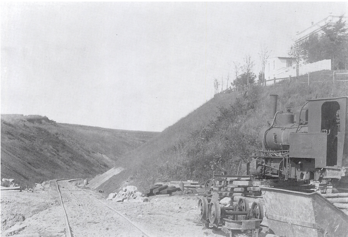
Gennemgravning til Troldhedebanen ved Ndr. Ringvej. Til højre i billedet ses villaen Fredensborg, ca. 1916.
