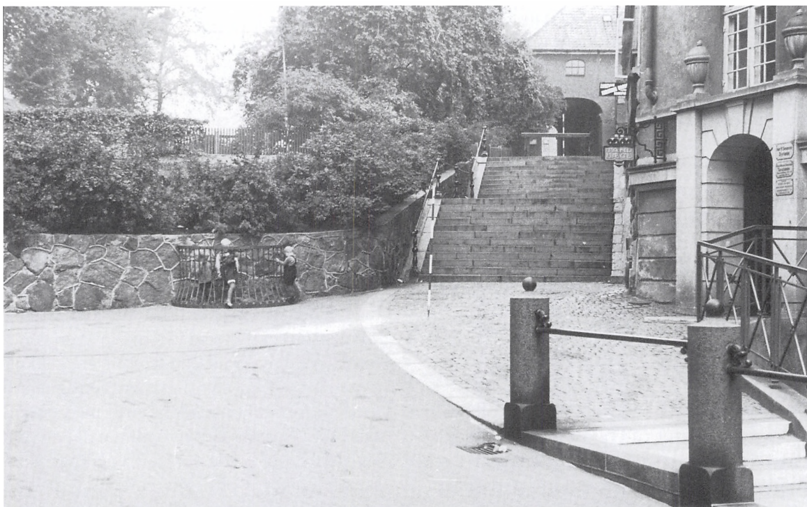
Opgangen til Koldinghus fra Slotsgade. Til højre Kvindernes Bygning, hvor skoleundervisningen blandt andet fandt sted.
