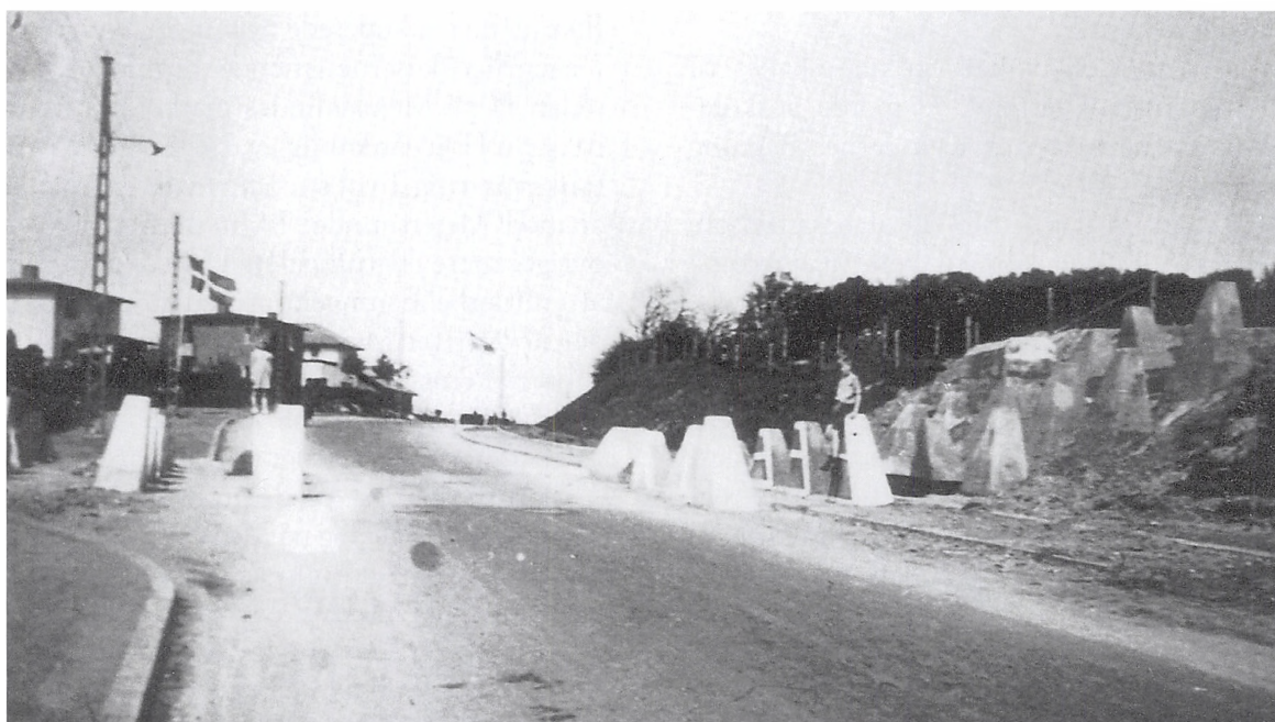
Tankspærring på Fynsvejbakke ved Petersbjerggård. Bakken til højre blev gravet væk og på tipvognstog kørt ned til opfyldning på havnen. Foto: Kaj Baagøe.
