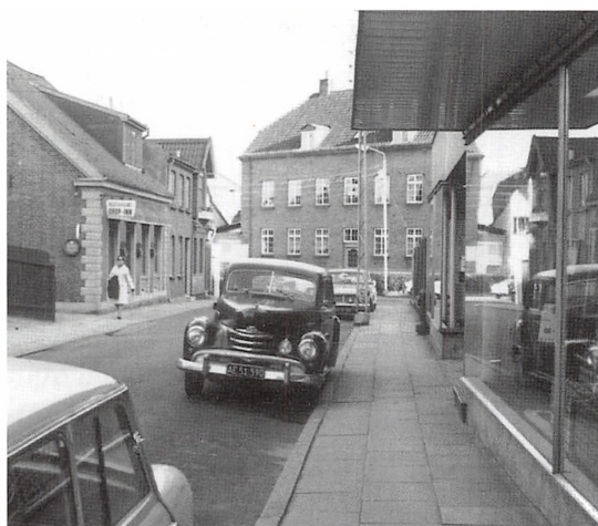
Karolinegade set fra Haderslevvej. Foto i Teknisk Forvaltning, 1972.
