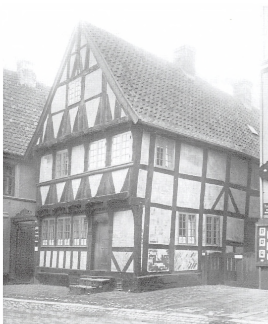
Helligkorsgade 18 er bygget i 1589. I 1600-tallet har der været flere huse med gavlen ud mod gaden som dette, men på de større grunde har husene haft langsiden mod gaden. Næsten alle byens huse var af bindingsværk. Foto ca. 1900.
