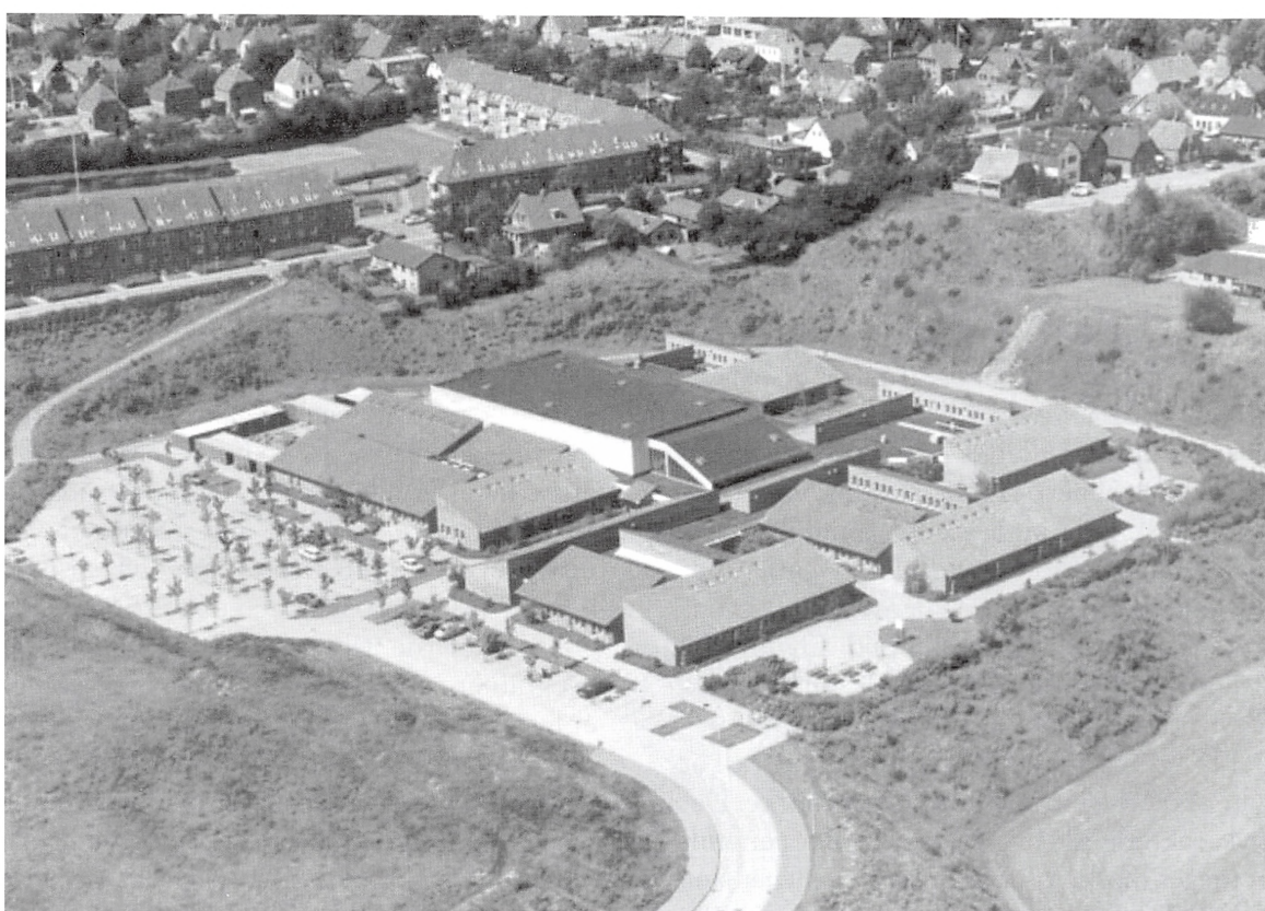
Luftfoto af det nybyggede Munkensdam Gymnasium.
