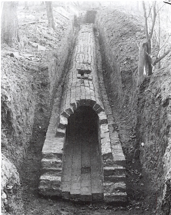
Udgravning af kloakledning på slotsbanken ved Koldinghus 1900.
