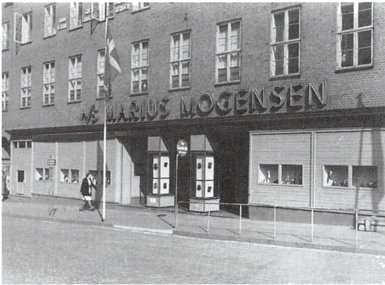
Butiksfacaden med trævinduer.
