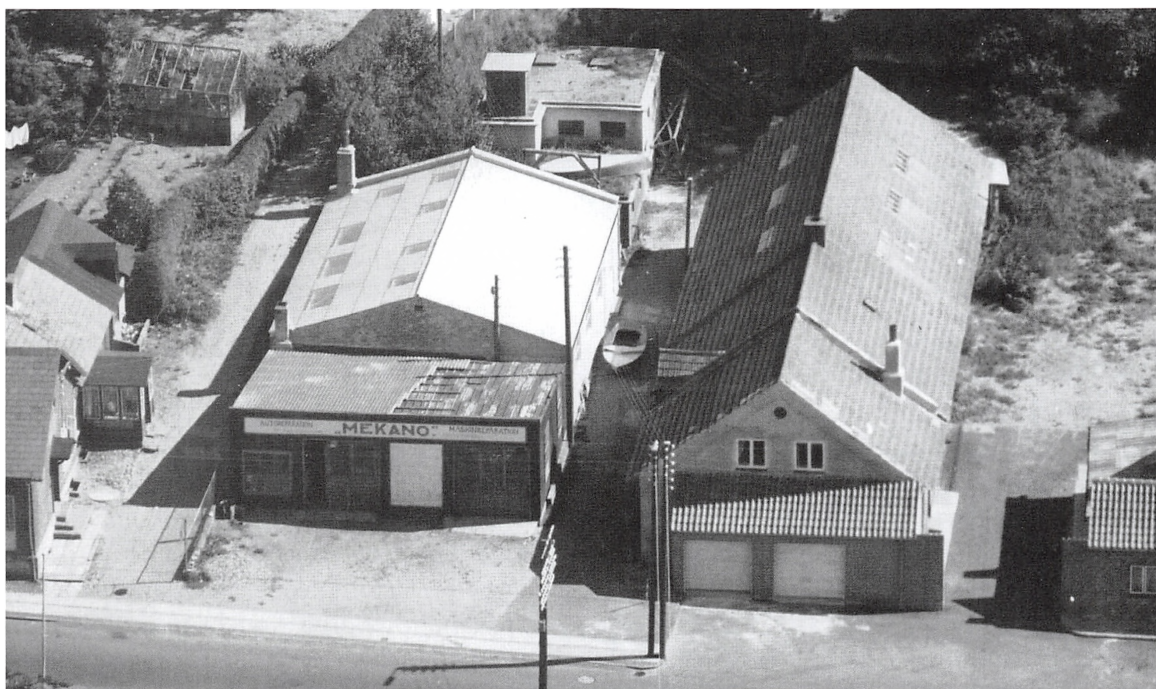
Luftfoto af Vejlevej 334-336. Den første del af hallen er taget i brug. Bygningen bagved med det lille tårn er Bramdrupdams første vandværk.
