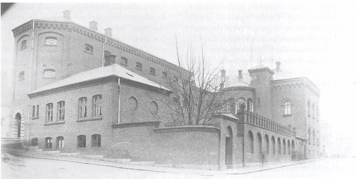
Kolding Arresthus omkring år 1910. Her sad falskmøntnerne fængslet under retssagen i april-maj 1919.
