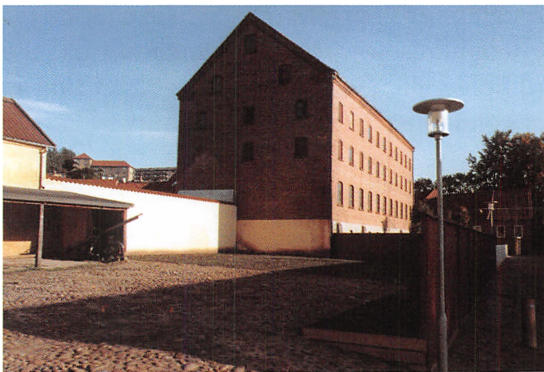
Graus pakhuis bag Låsbygade 110 omdannet til ungdomsboliger. I baggrunden Kikkenborggården. Foto: Sten Krarup, Teknisk Forvaltning, 1985.
