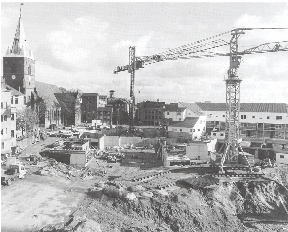
AAB i gang på Bredgadepladsen, 1988. Foto: Sven Erik Jacobsen.
