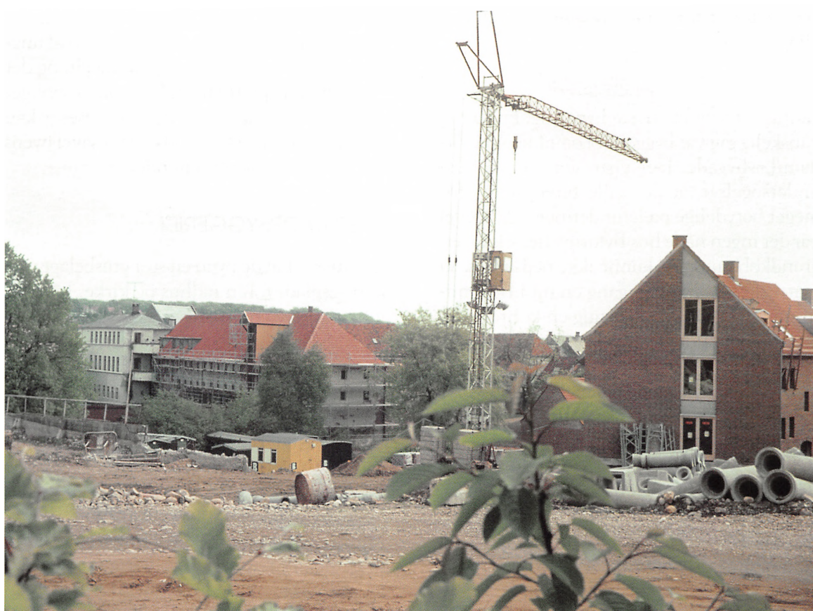
Konsul Graus Gade-byggeriet under opførelse, maj 1981. Foto: Gudrun Hechmann.
