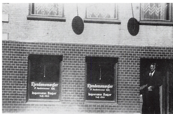
Ingemann Bager stående ved sin ejendomsmæglerforretning under Astoria. Foto fra 1944.
