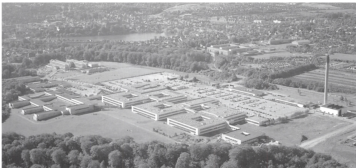
Det nye Kolding sygehus på Dyrehavegaards mark fotograferet i 2000.
