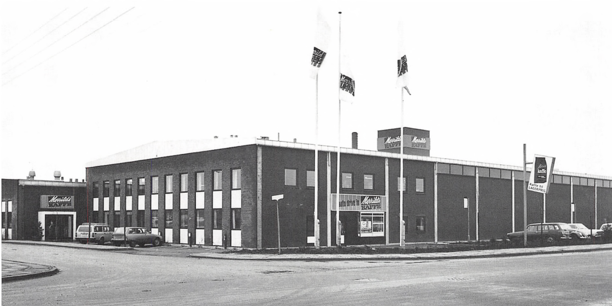
Fabrikken på Lærkevej. På modsatte side ses råvarelageret.
