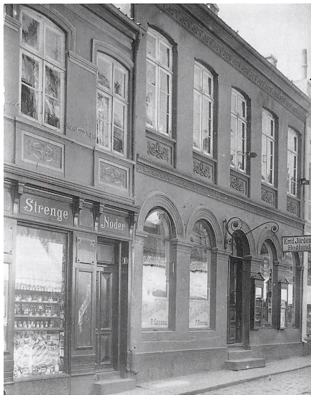
Låsbygade 23-25. Husene har pudsede facader med hovedgesimser og formstensfriser, og under vinduerne er der henholdsvis malede og plastiske dekorationsfelter.
