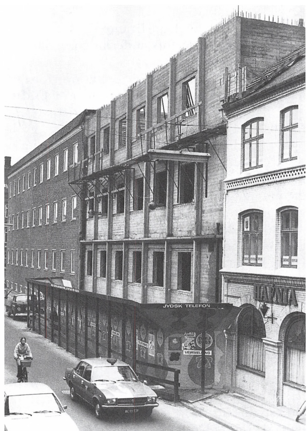
Byggefase 3, foto fra ca. 1970
