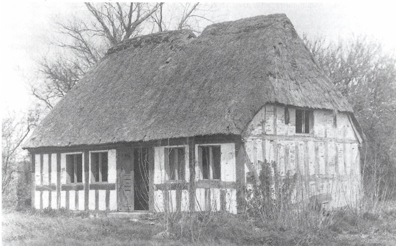
Huset i Starup under nedbrydning
