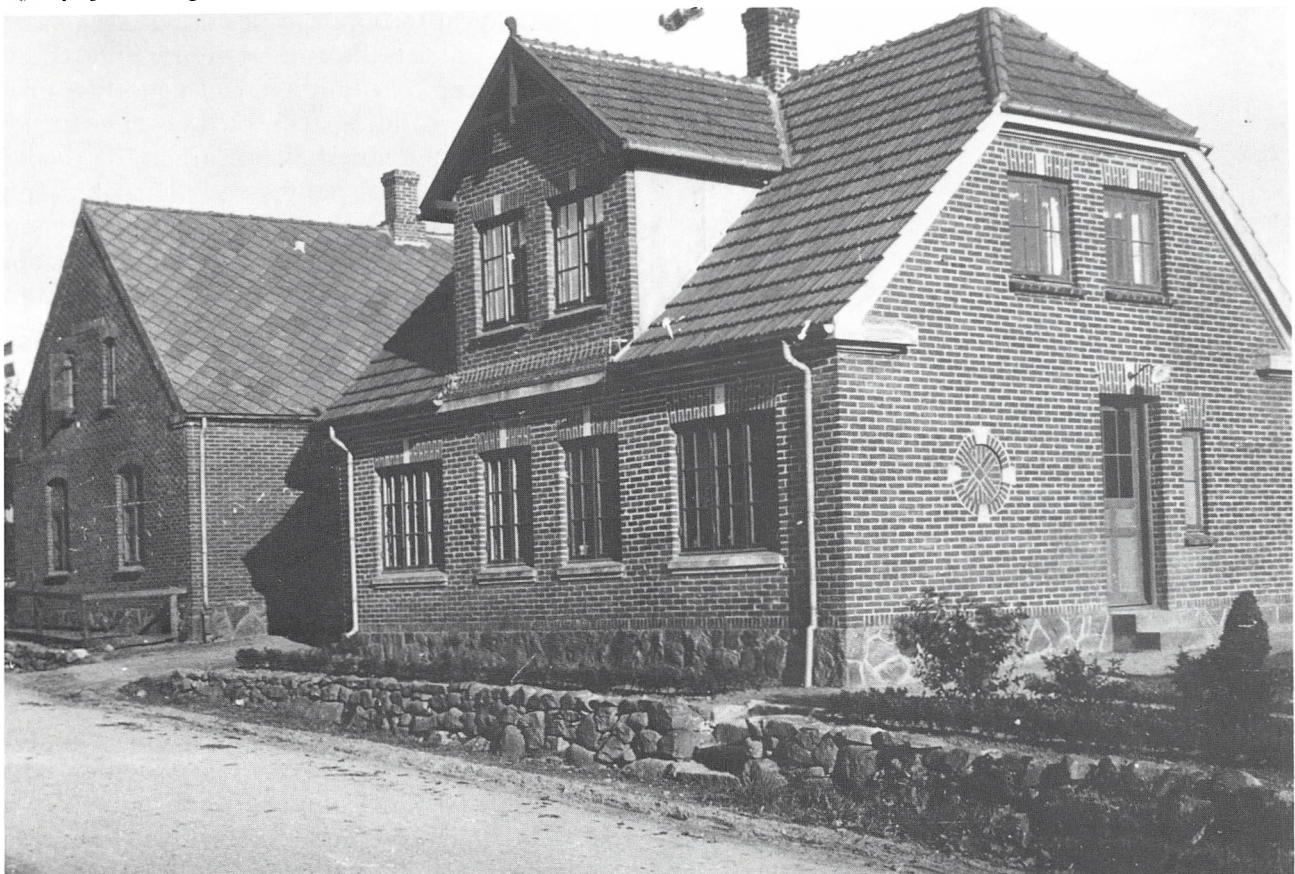
Hjarupvej 11, tidligere Vonsild Elektricitetsværk.
