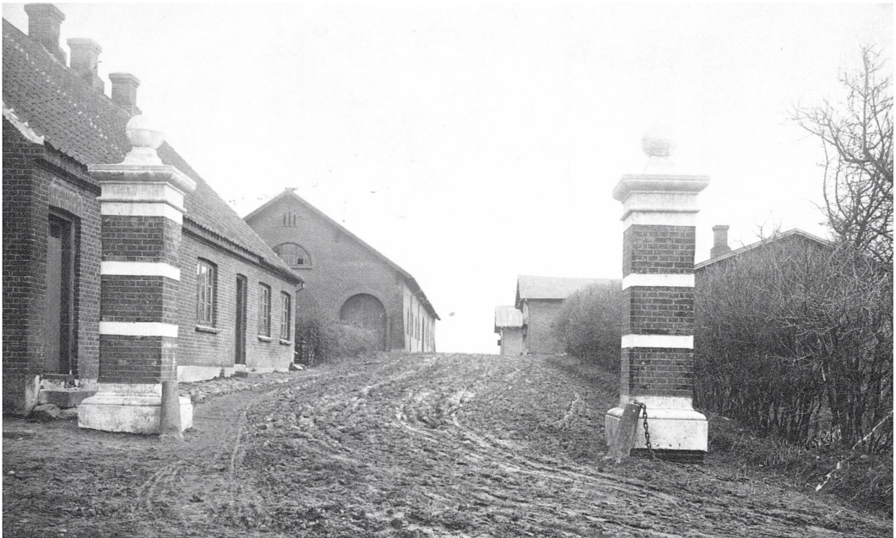
Opkørslen til Dyrehavegård, 1920. Bygningen til venstre havde tre lejligheder.
