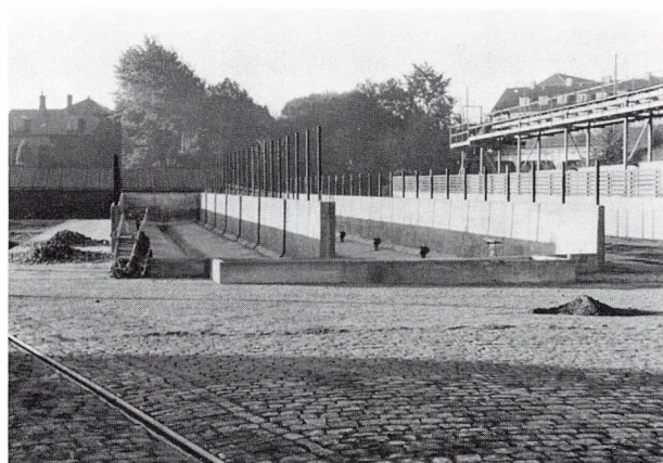
Det færdige roemagasin. Tippegruben for dette magasin blev først udført i 1953. Til højre i billedet ses roemagasin nr. 1, som blev udført i 1949. Oven over magasin nr. 1 ses transportbåndet fra tippegruben. (Foto: H.C. Ervald, 1952)
