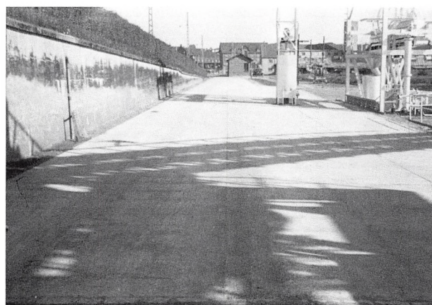
Til højre i billedet ses tippegruben. Til venstre for den ses et jernstativ. Det er en del af hejseanlægget for tippning af roevognene. I tippegruben ses en stor jernspand, der er en del af den automatiske roeprøvningsudtagning. Spanden befandt sig nede i gruben, når vognene blev tippet og tomt for roer. (Foto: H.C. Ervald, 1950)
