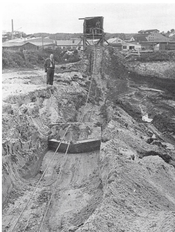
Fylden trækkes op på slisken og falder ned i tipvognene. Til venstre ses H. C. Ervald. (Foto: P. Thastum, 1951)
