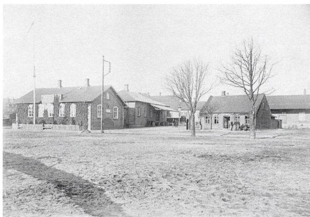
Toldkammerbygning på havnen opført 1886. Foto fra 1916.
