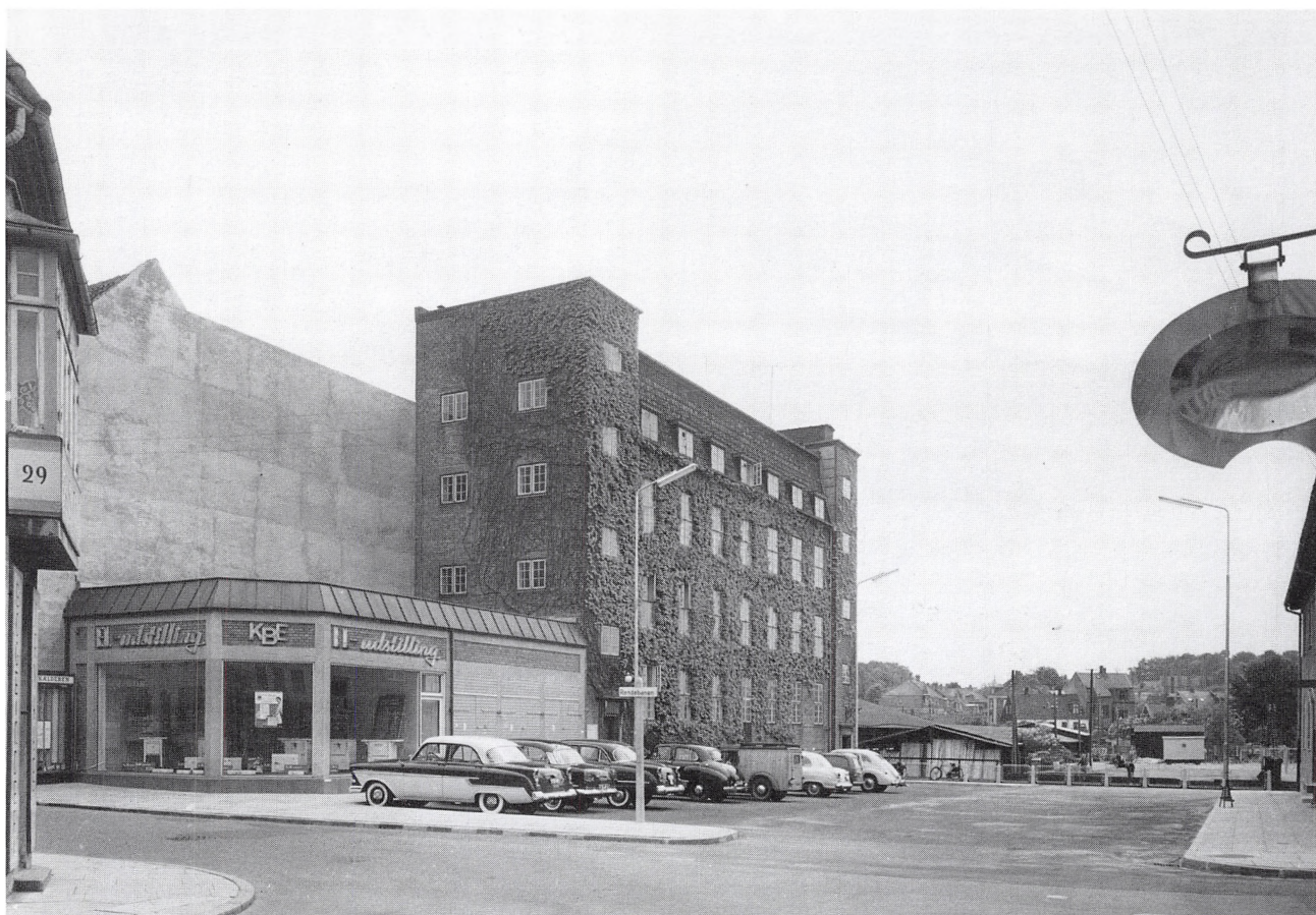
Demonstrationslokalet og til højre herfor transformatorstationerne og administrationsbygningen.
