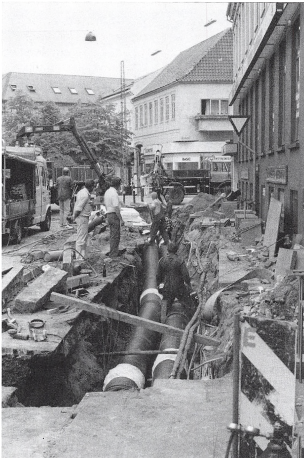
Renovering af fjernvarmerør, Rendebanen maj 1988.
