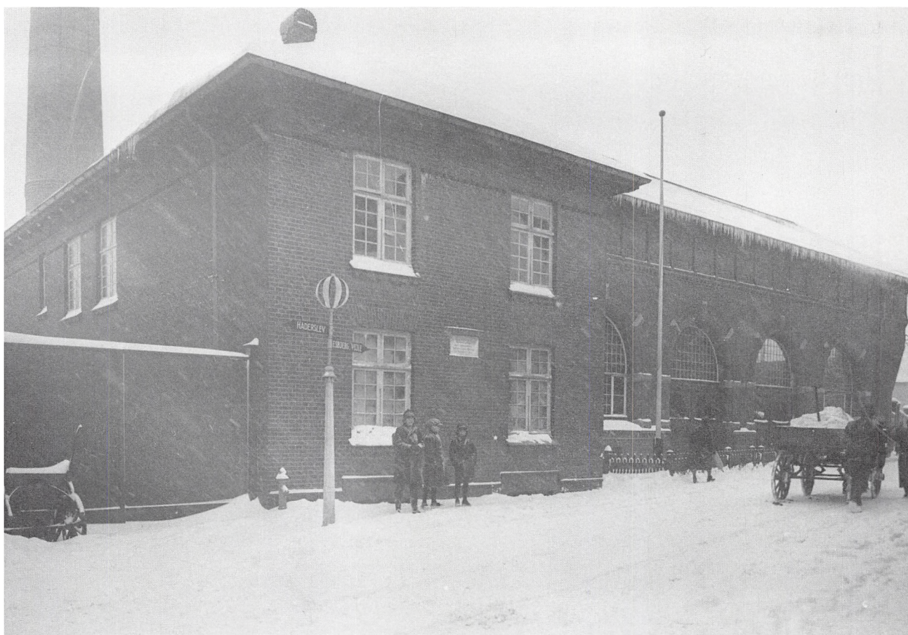
Elektricitetsværket set fra Rendebanen sidst i 1920'erne. Til højre i billedet ses det knæk, som bygningen fik ved udvidelsen p.g.a. gadens forløb.
