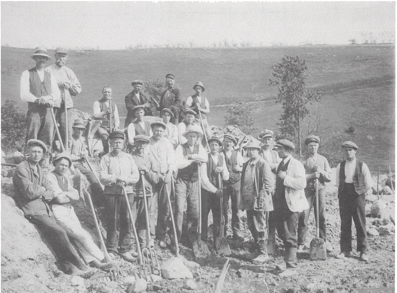
Arbejdere ved Harteværket.
