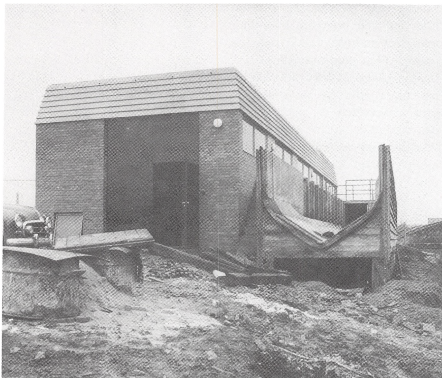
Pumpehuset med afløbsrenden. Foto Lisberg 1957.
