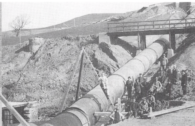
Fra arbejdet ved Harteværket.
