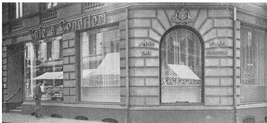
Jernbanegade 26. Boesens Conditorei.
