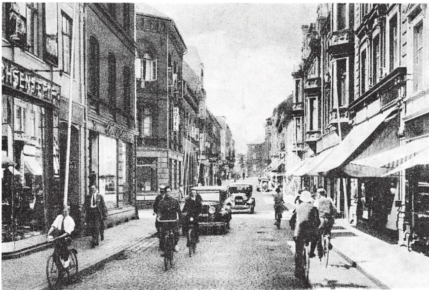
Højskolehjemmets bygning i Jernbanegade.
