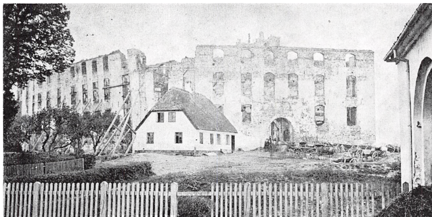
Koldinghus 1864. Ruinen set fra Staldgården. Sydfløjens sydmur er understøttet, men står endnu i fuld højde. Foto: E. Brandt, Flensburg.
