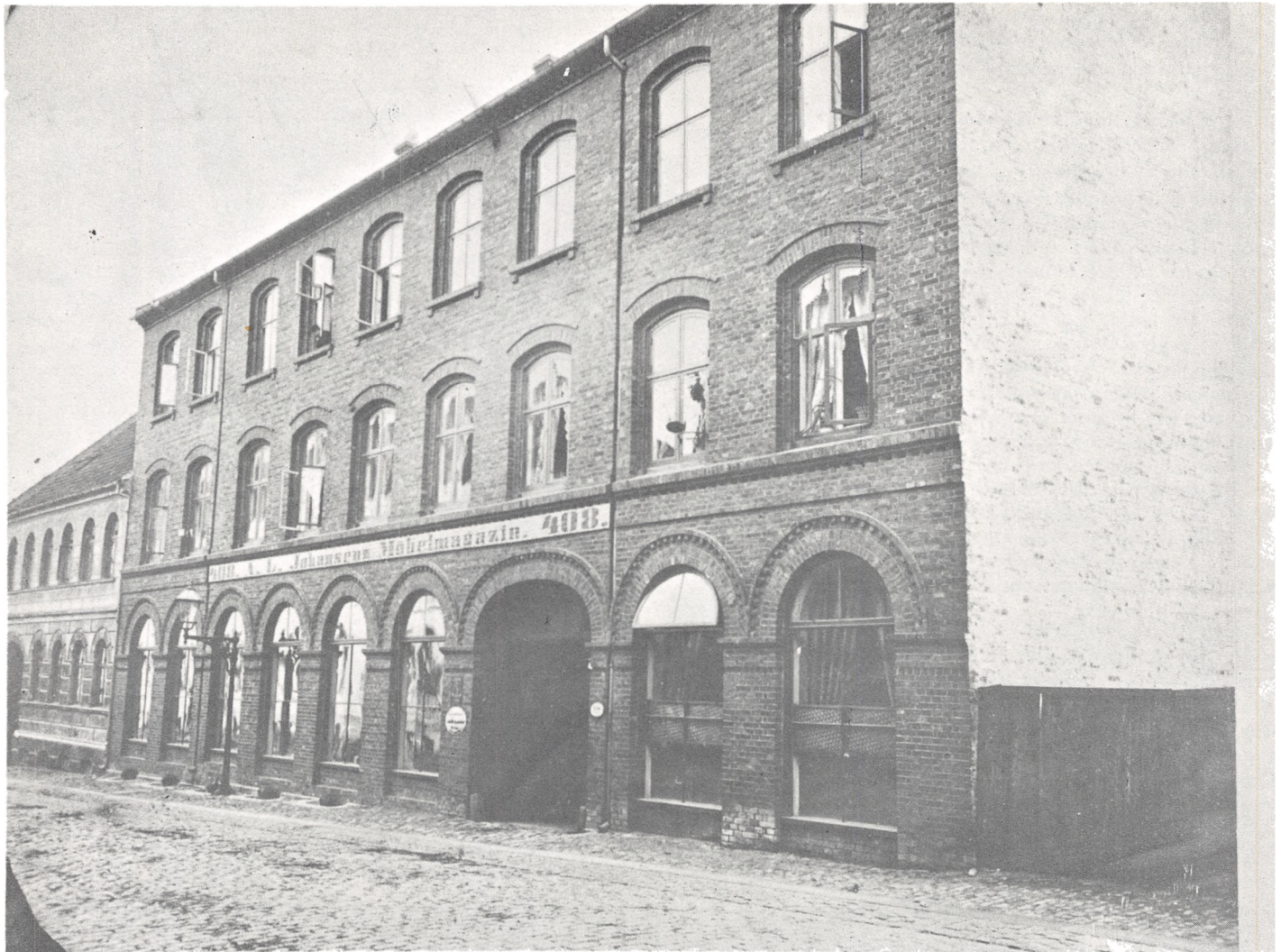
Ikke ret mange vil kunne huske denne bygning i Jernbanegades midterste del. Men det er altså firmaet A. L. Johansen. Det tør siges, at der er sket forandringer i årenes løb, når man nu betragter den flotte facade og i det hele taget den kolossale udvikling, der er sket.
